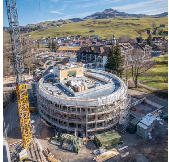
Kein Winterschlaf im Badehaus – die Bauarbeiten gehen wie geplant voran.
