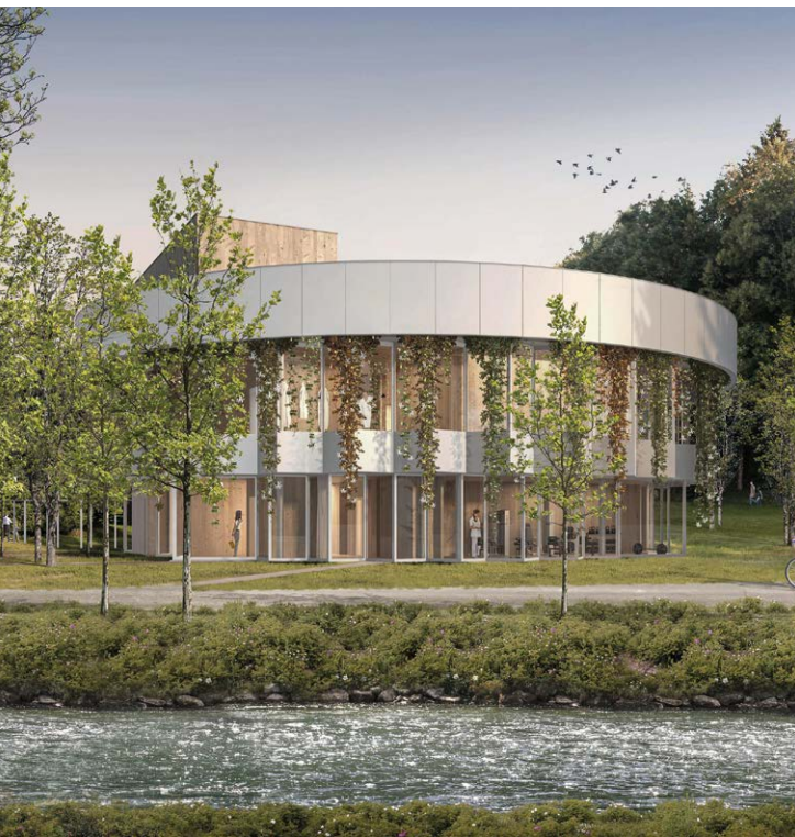
Die Vorbereitungen für den Bau des neuen Bade- und Saunahauses laufen auf Hochtouren.
